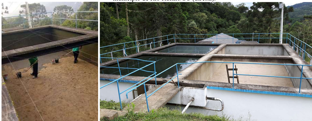
Figura 13 - Operação de remoção da camada Schmutzdecke (esquerda) e visão de uma unidade de Filtração Lenta no município de Rio Rufino/SC (direita).
