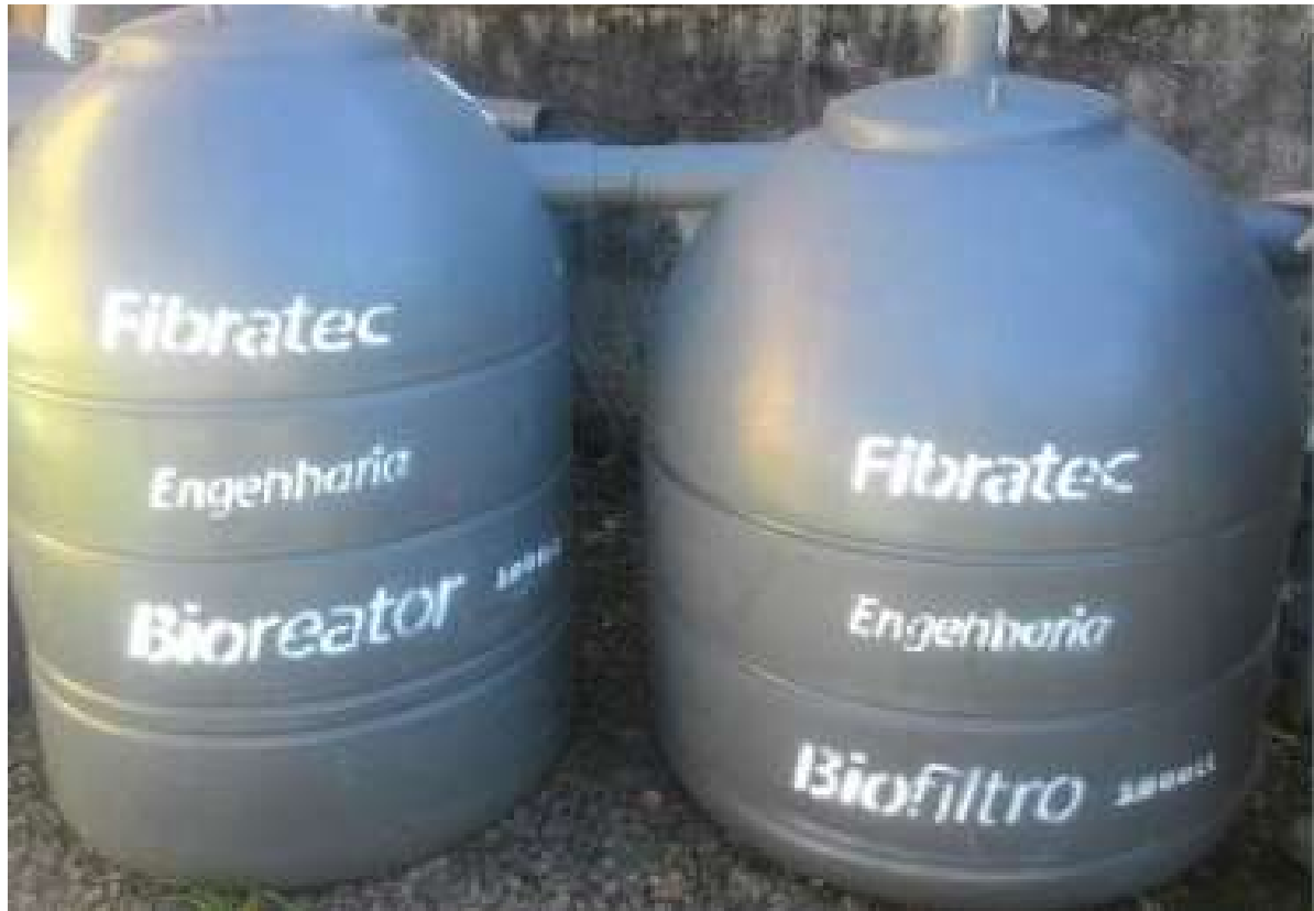
Figura 24 - Sistema tanque séptico e filtro anaeróbio.
