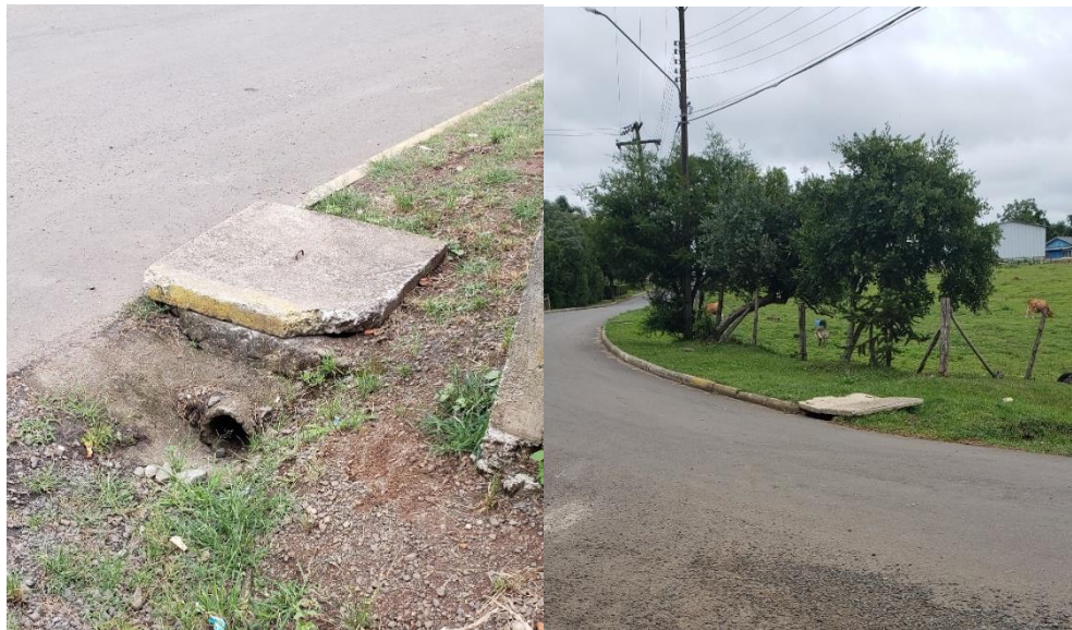
Figura 20 - Exemplos de ruas com drenagem pluvial no município de Ponte Alta.
