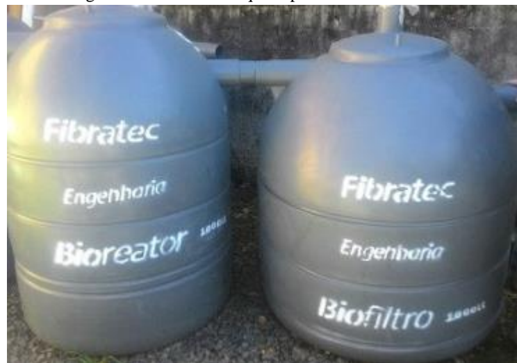
Figura 28 - Sistema tanque séptico e filtro anaeróbio.
