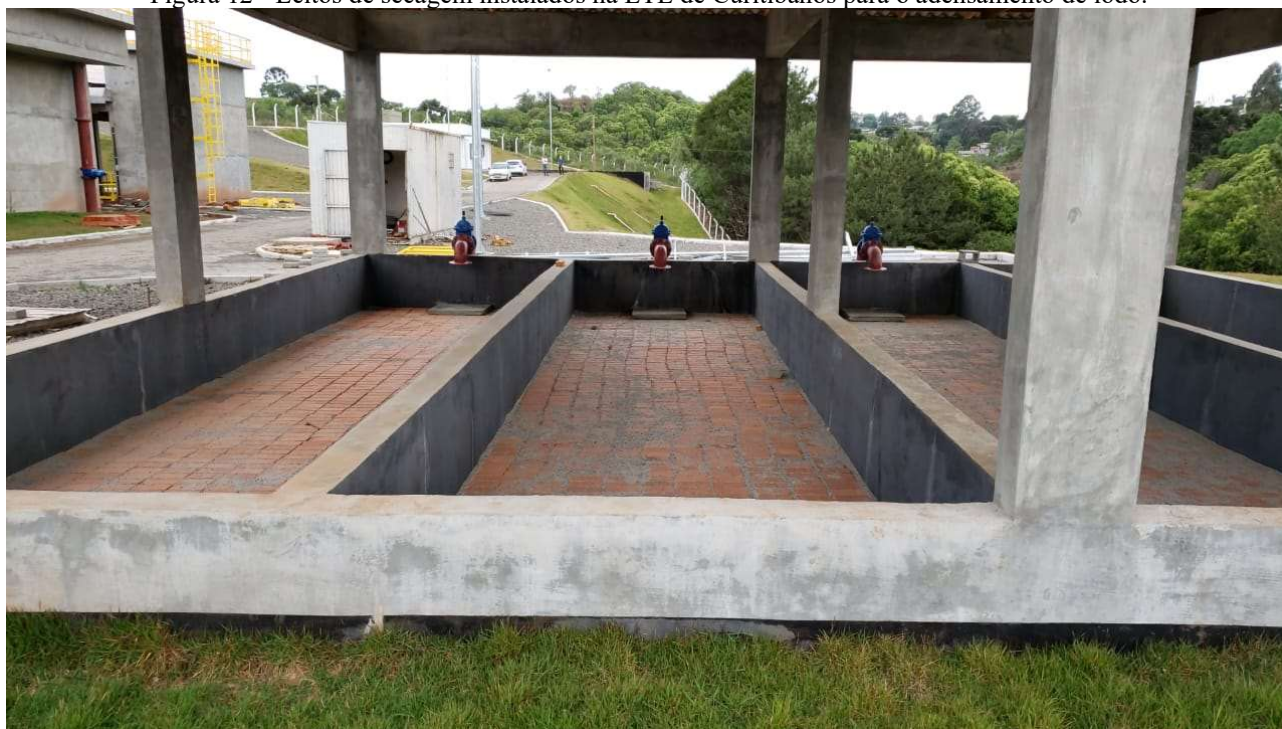
Figura 12 - Leitões de secagem instalados na ETE de Curitibaanos para o adensamento de lodo.
