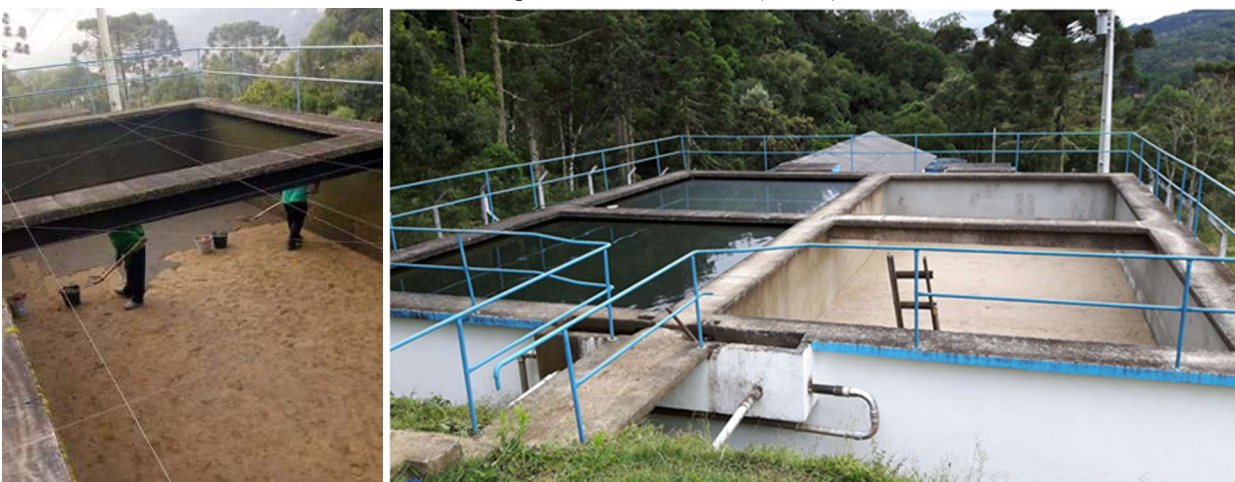
Figura 9 - Operação de remoção da camada Schmutzdecke (esquerda) e visão de uma unidade de Filtração Lenta no município de Rio Rufino/SC (direita).
