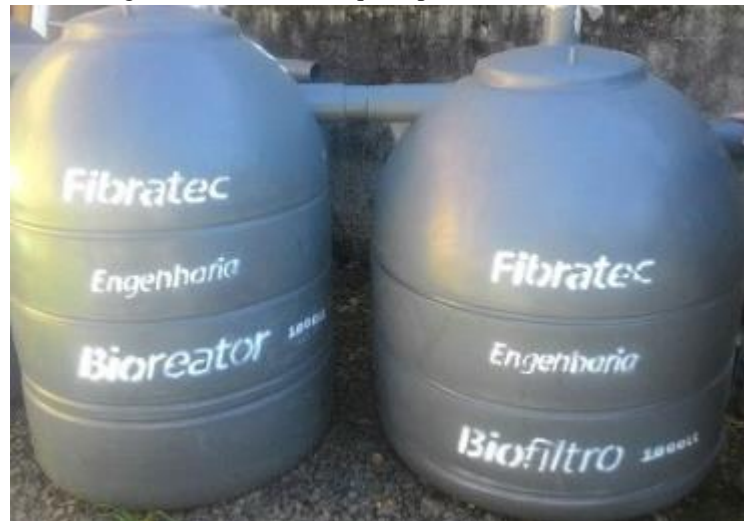
Figura 12 - Sistema tanque séptico e filtro anaeróbio.
