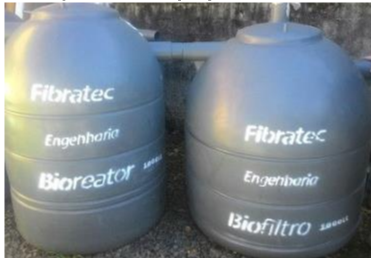
Figura 27 - Sistema tanque séptico e filtro anaeróbio.
