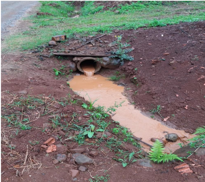
Figura 22 - Rede pluvial a céu aberto.
