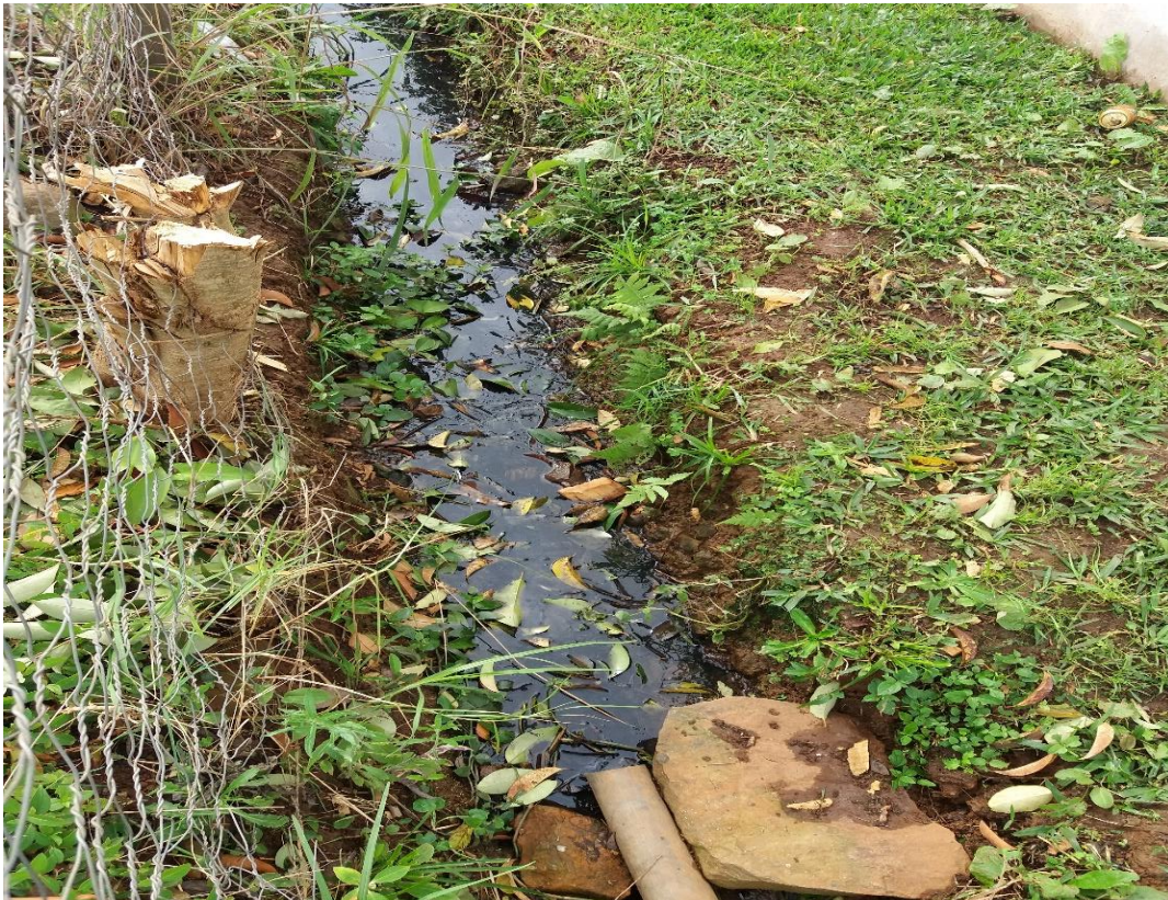
Figura 19 - Vala construída em terreno para o despejo do esgoto bruto.
