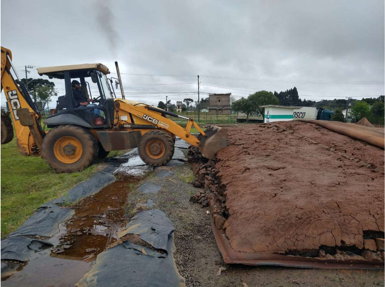
Figura 8 – Aspecto visual do lodo obtido após desidratação em bag geotêxtil na ETA de Curitibaanos.
