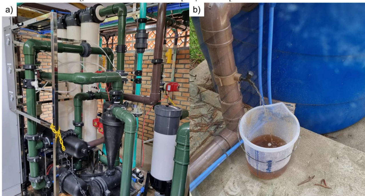
Figura 13 – a) Visão do sistema de membranas de UF instalado na região da Grande Florianópolis. b) Subproduto gerado no tratamento devido às operações de limpeza da membrana.
