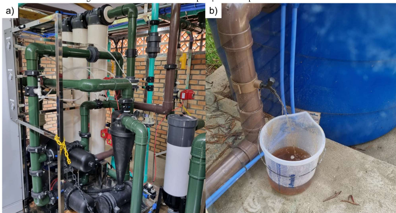
Figura 10 – a) Visão do sistema de membranas de UF instalado na região da Grande Florianópolis. b) Subproduto gerado no tratamento devido às operações de limpeza da membrana.
