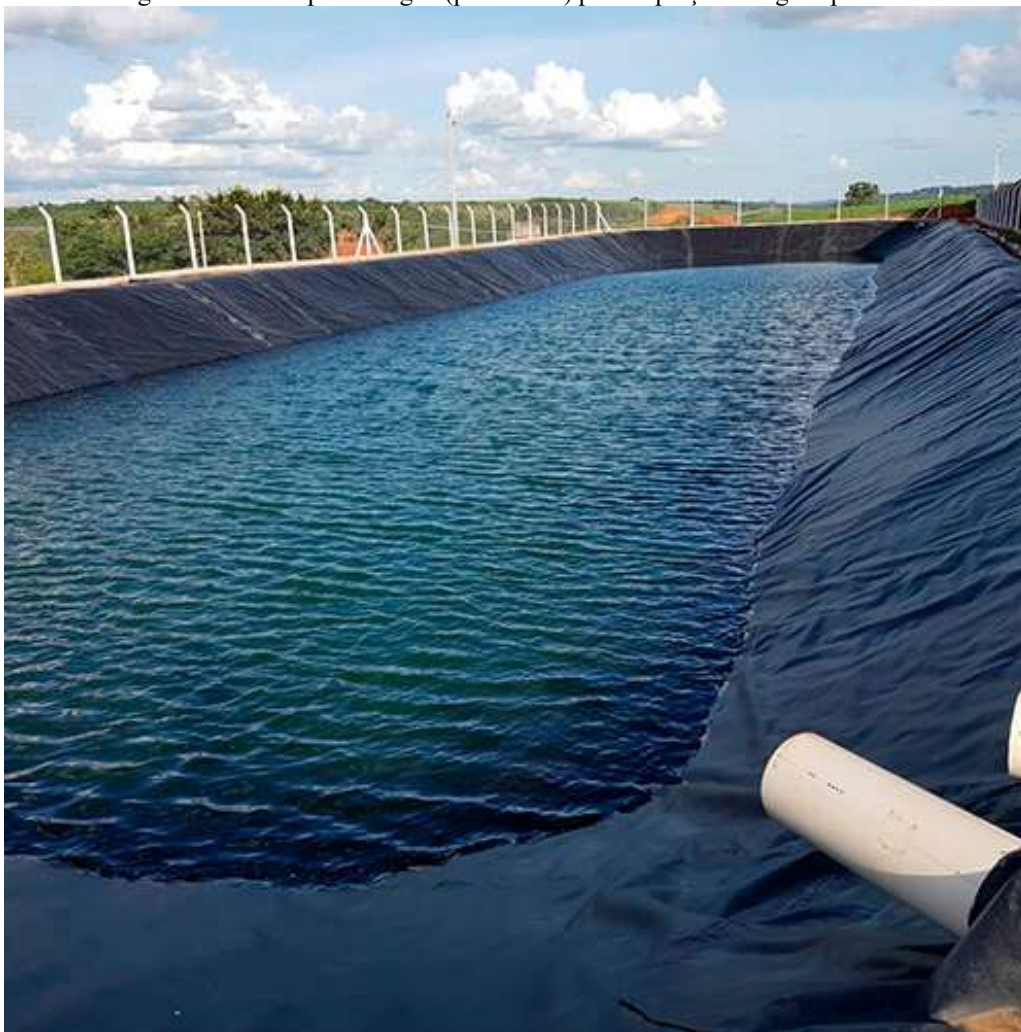
Figura 12 – Exemplo de lagoa (piscininha) para captação de águas pluviais.
