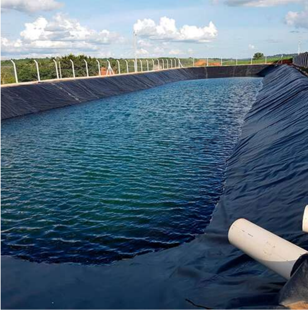
Figura 11 – Exemplo de lagoa (piscininha) para captação de águas pluviais.
