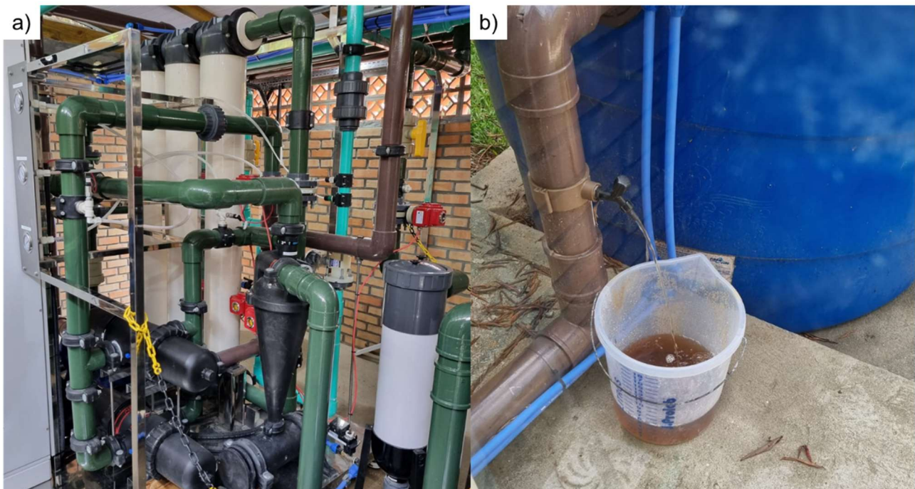
Figura 9 – a) Visão do sistema de membranas de UF instalado na região da Grande Florianópolis. b) Subproduto gerado no tratamento devido às operações de limpeza da membrana.
